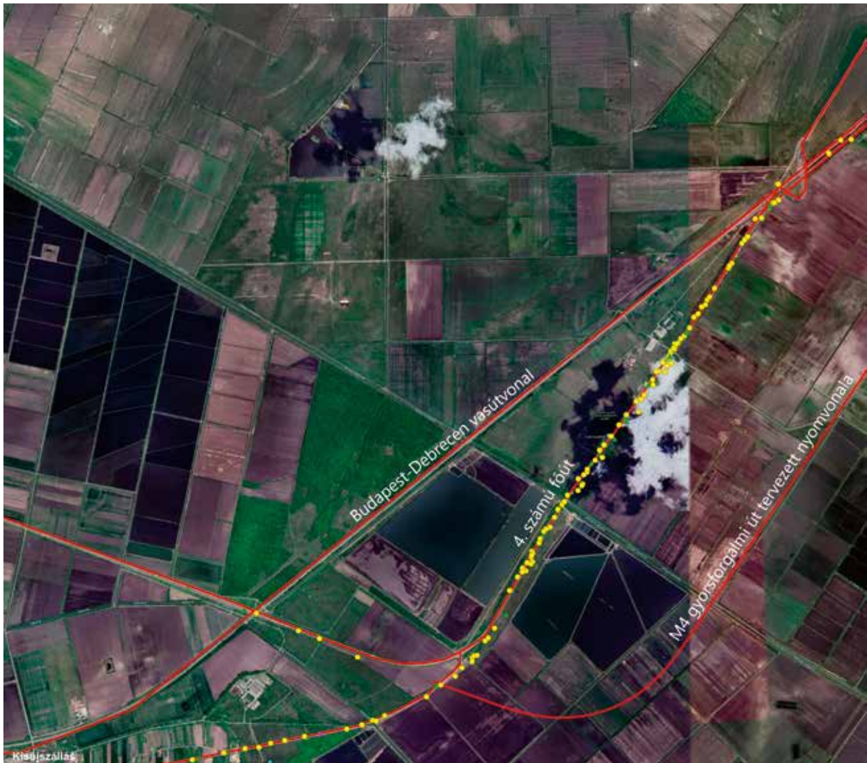
11. ábra: Erősen fragmentált táj Kisújszállás és Karcag között. A meglévő főút és vasúti fővonal mellett egy gyorsforgalmi út építése is folyamatban van / Drastically fragmented landscape between Kisújszállás and Karcag (Hungary). Beside the existing Main Railway and Main Road and roads, a new motorway is being built
