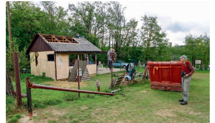
2025. február közepén az új épület már szerkezetkész volt
