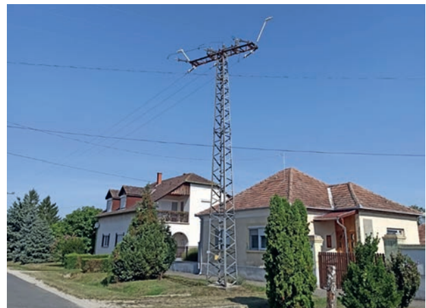
16. ábra: Településeink a fehér gólyákat ( Ciconia ciconia ) veszélyezteteti leginkább a sok csúcsi helyzetű oszlopkapcsoló, amelyek az utólag szerelt madárkiülők ellenére számos esetben pusztulnak el a fiatal, épp kirepülő madarak. Megoldást a csúcsból eltávolított, oszloptörzsre szerelt, lefelé fordított készülék jelenthet (fotó: György Előd) / In settlements, White Storks are most endangered by the many switch gears positioned at the top of the pole, on which often die freshly fledged juvenile birds, despite any retrofitting installed bird perching rods. A solution could only be a device removed from the top and mounted in a downward facing position on the pole trunk
