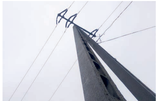
12. ábra: Hazai fejlesztésű kereszttartó burkolattal (zöld „papucs”) és modern szigetelőburkolattal (fekete szigetelés) is ellátott, hiánytalan burkolású oszlop, amely alatt egy áramütött zöld küllőt találtunk, 2022, Fertőújlak. (különösen odúlakó madarak hajlamosak épp a műanyag burkolatok alá eldugni kincseiket) (fotó: Győrig Előd) / Retrofitting pole, equipped with the Hungarian developed cross-arm insulator cover (green „slipper”) and a modern insulating cover (black), under which we found an electrocuted European Green Woodpecker, 2022, Fertőújlak (especially bird species breeding in nesting holes tend to hide their treasures under the plastic covers)
