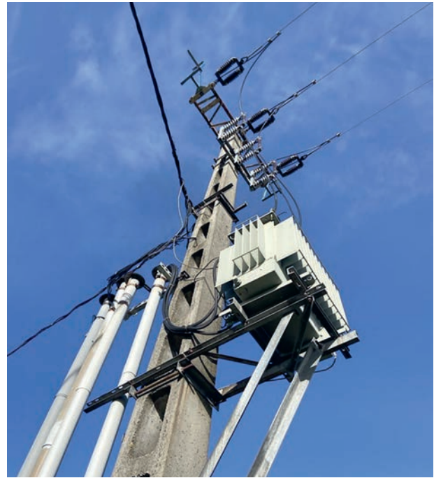
15. ábra: Kiegészítő szerelvényekkel átalakított OTR-állomás Csér településen. Alulról jól érzékelhető a régi, rövid feszítőszigetelők mérete, melyen egy fehér gólya ( Ciconia ciconia ) szárnya átér a csupasz sodronyig. A gyöngybagoly ( Tyto alba ) pedig a burkolatlan trafócsapok áldozata is lehet (fotó: György Előd) / OTR station retrofitted with additional fittings – in the settlement of Csér. From below it’s clearly visible the short size of the old tension insulators, through which a White Stork’s wing can reach the bare wires. Western Barn Owls could be victim of the uncovered transformer taps
