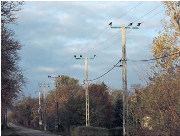
13. ábra: A kép előterében az előzőhöz hasonlóan hazai fejlesztésű kereszttartó burkolattal („magyar papucs”) és modern szigetelőburkolattal (fekete szigetelés) is ellátott, utólag burkolt oszlopok (fotó: Solt Szabolcs) / Retrofitted poles, equipped in parallel with the Hungarian cross-arm insulator cover and a modern insulating cover (black) in the foreground
