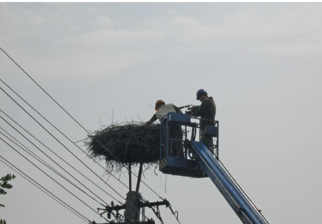
Fészekmagasítóra épült gólyafészek ellenőrzése
