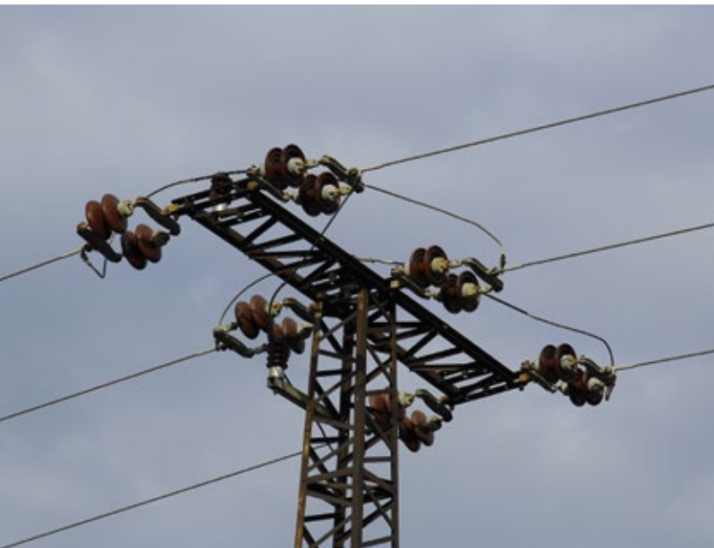
Középfeszültségű hálózat egysíkú, rácsos keresztartós feszítőoszlopa
